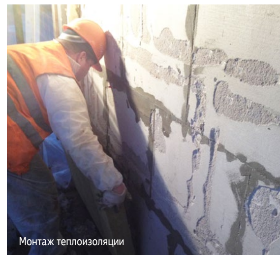
Нанесение скрепляющего раствора для монтажа теплоизоляции
